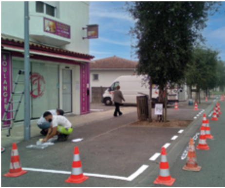
Ave de l'Océan - Aménagement arrêts minutes
