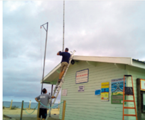
Poste MNS - Réparation antenne radio
