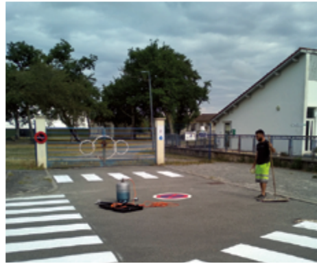
Parking des écoles - Aménagements sécuritaires
