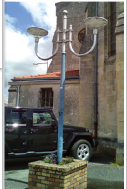
Remplacement luminaires par des LED
