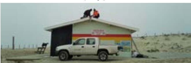
Remise en état du faitage du poste MNS arraché par la tempête
