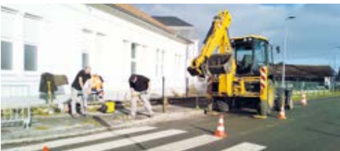
Sécurisation du trottoir et passage piéton aux abords de l'école
