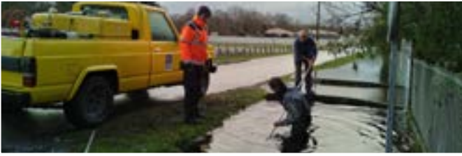
Interventions suite aux inondations : débouchage ponts et fossés, sécurisation routes inondées
