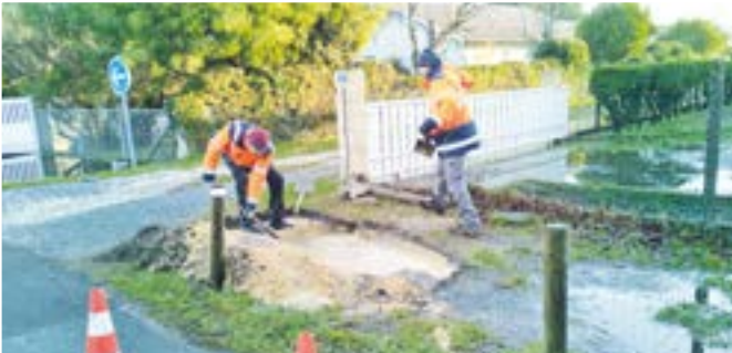
Ouvertures sous trottoirs lorsque les buses se sont révélées être écrasées
