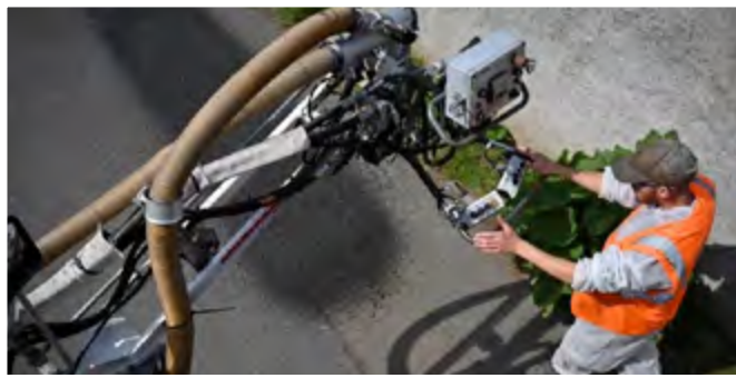
Réfection voies communales - "Technique enrobé projeté" Participation au chantier mobile
