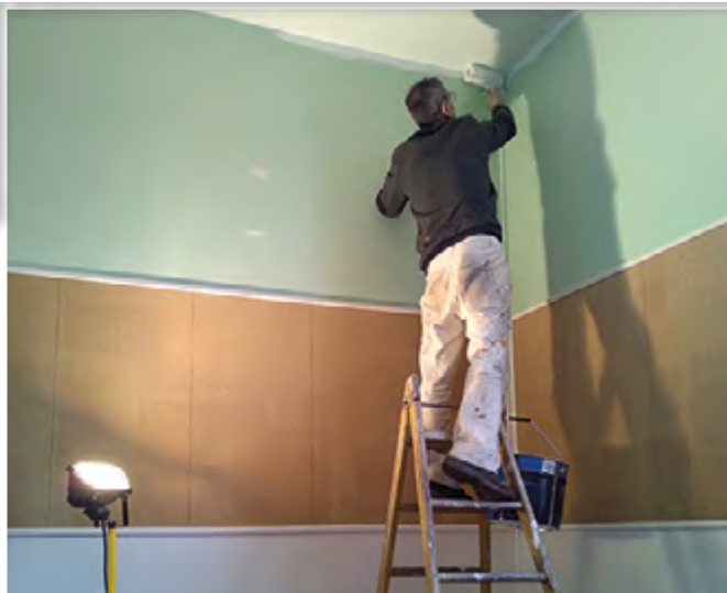
Rénovation bureau mairie
