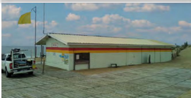
Poste de secours repeint aux nouvelles couleurs réglementaires
