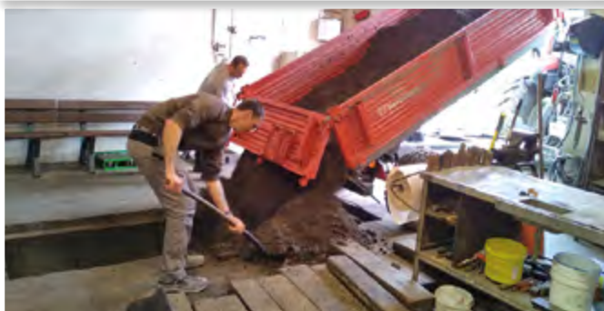
Réfection des ateliers - Rebouchage d'une fosse non conforme
