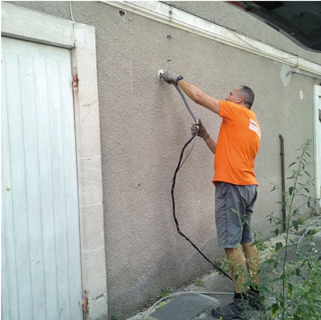
Mise en oeuvre alimentation électrique frigo « Zéro Gaspi »
